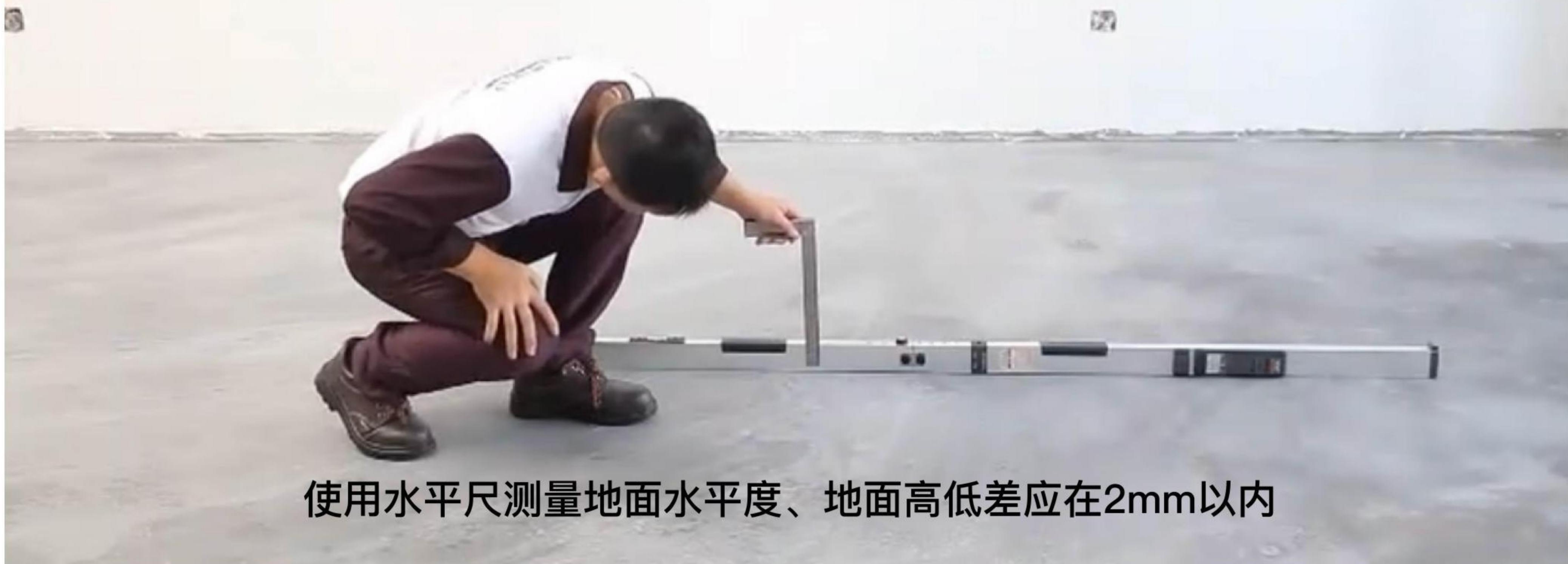
使用水平尺测量地面水平度、地面高低差应在2mm以内
