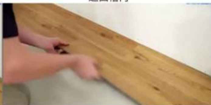
7. 将长边凸槽插入第一排地板的长边凹槽内
