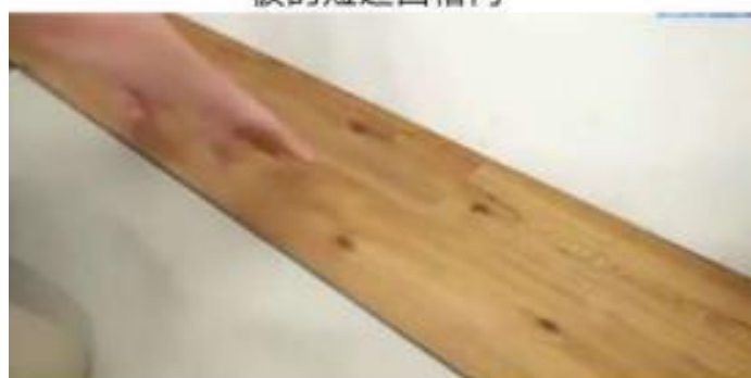
8. 将短边凸槽插入第二排第一块地板的短边凹槽内
