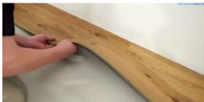
8. 将短边凸槽插入第二排第一块地板的短边凹槽内
