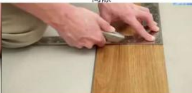
2. 将地板与墙面之间预留出 0.5-1cm 的间隙
