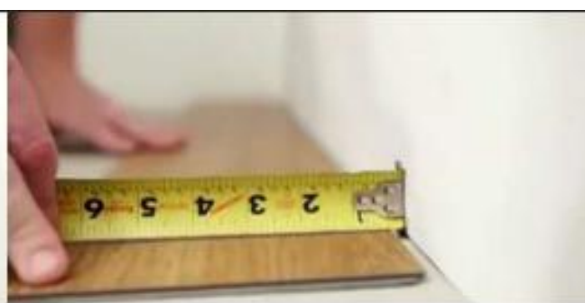
2. 将地板与墙面之间预留出 0.5-1cm 的间隙
