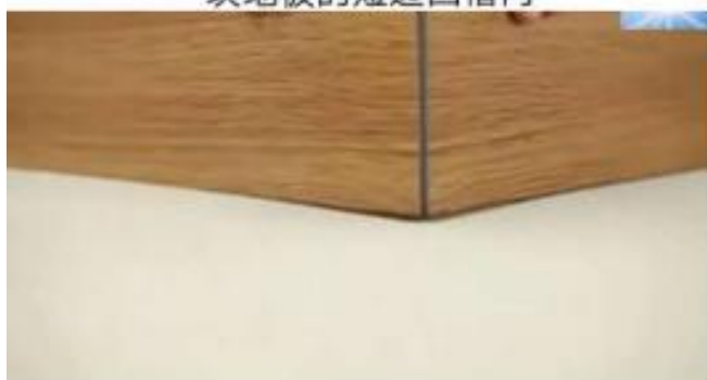
3. 将第二块地板的短边凸槽插入第一块地板的短边凹槽内
