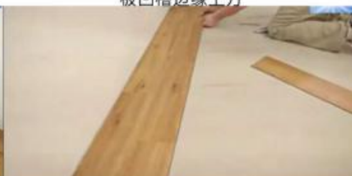
9. 使长边凸槽恰好位于第一排地板凹槽边缘上方
