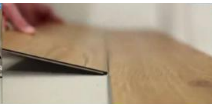
7. 将长边凸槽插入第一排地板的长边凹槽内
